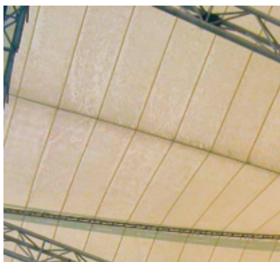
Zdjęcie 2: Problemy z przyleganiem warstwy lakieru negatywnie wpływają na przezroczystość tkaniny. W miejscach, gdzie lakier odpada, powłoka jest narażona na zanieczyszczenie i działanie promieni UV.
